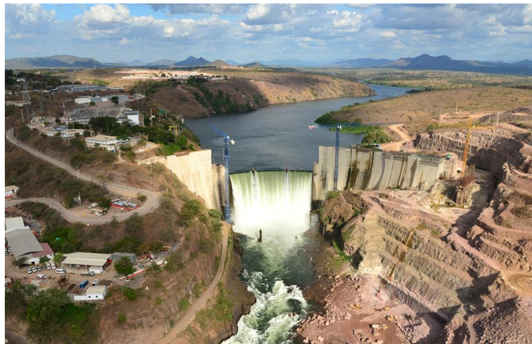
Figura 4 -Aproveitamento Hidroeléctrico de Cambambe. Adaptado de [8].
