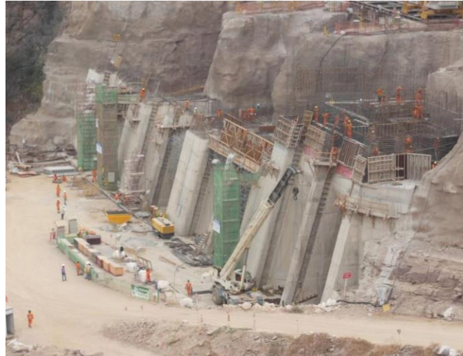
Figura 8 – Construção da tomada de água do novo circuito hidráulico. Retirado de [1].
